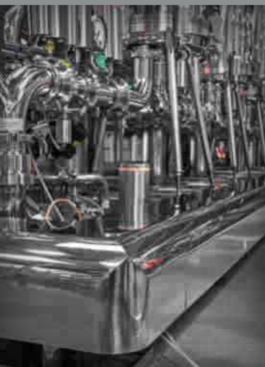
Canala perimetrale con angolo
