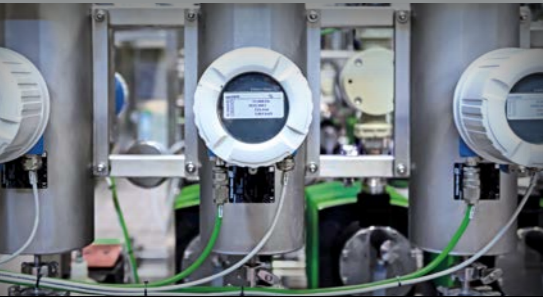
Mesure du débit du groupe d'injection des dosages
