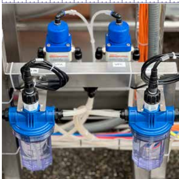
HÁZ PH-MÉRŐ ELEKTRODÁK SZÁMÁRA
