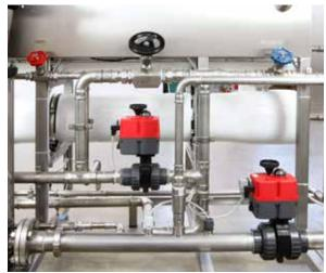
**VANNES DE RÉGULATION MANUELLES** Ils permettent une gestion précise de la pression sur la membrane.
