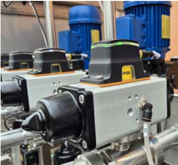
气动阀×14，均配备执行器和接近传感器
