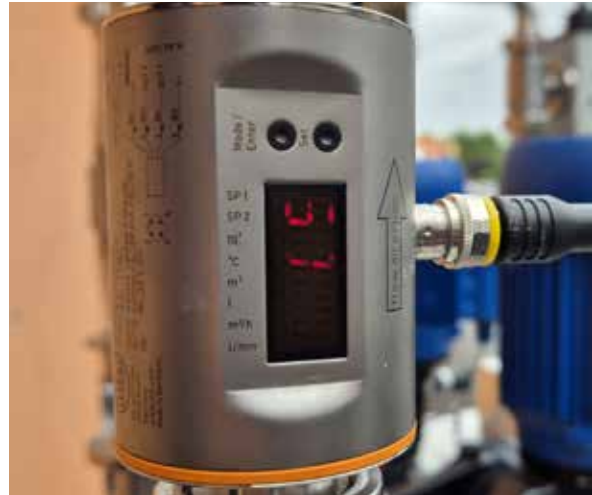
1 DURCHFLUSSMESSER JE PUMPE/PRODUKT
