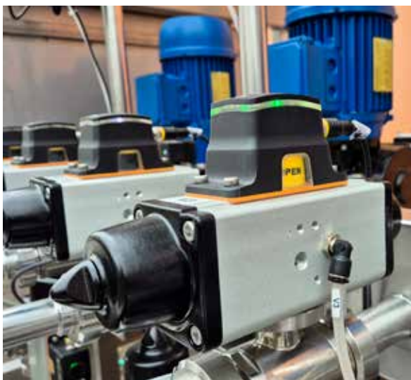
N. 14 PNEUMATIKUS SZELEPEK működtetővel és közelségérzékelővel
