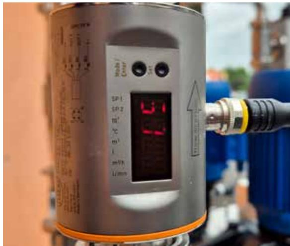
**1 MEDIDOR DE VAZÃO DE BOMBA/PRODUTO**
