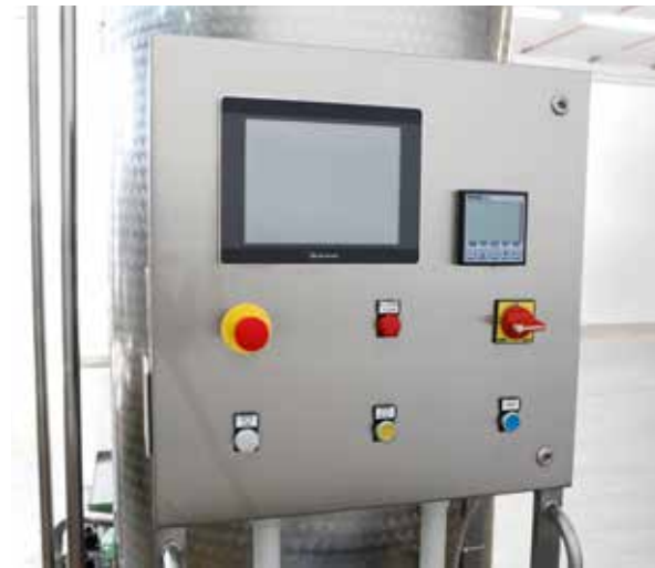
CUADRO ELÉCTRICO CON PH-METRO
